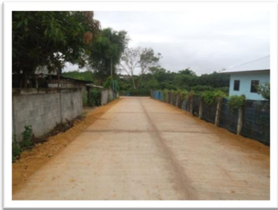
โครงการก่อสร้างถนน คสล. บ้านสวนทราย
