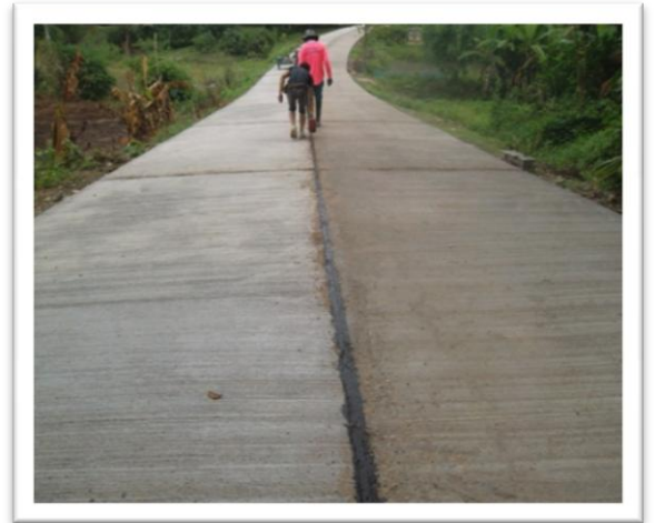
โครงการก่อสร้างถนน ค.ส.ล. ทางเข้าป่าสุสาน บ้าน ค้ำฮ่อ
