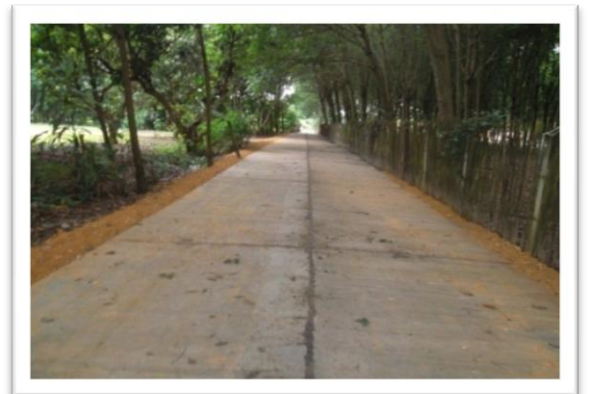
โครงการจ่ายยเงินสะสม โครงการก่อสร้างถนน คสล. บ้านห้วยสะนาว
