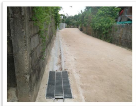
โครงการก่อสร้างท่อระบายน้ำพร้อมบ่อพัก หน้าบ้านผู้ช่วยถา บ้านจูน
