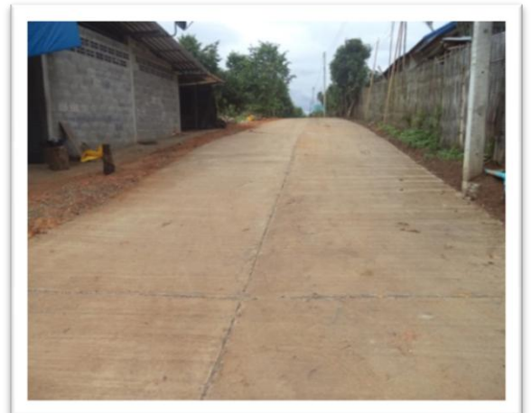
โครงการก่อสร้างถนน คสล. บ้านค้างฮ่อ
